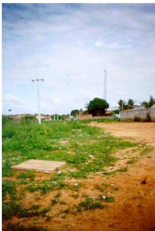
FOTO 16 – Vista da cidade de Catarina a partir da ETA.
